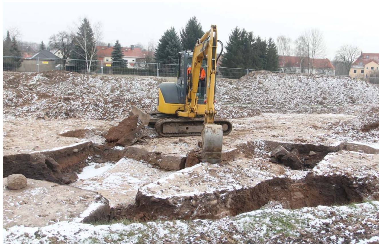
Abb. 7. Bagger bricht Schollen aus dem zeitweise bis zu 40 cm tief durchgefrorenen Boden.
