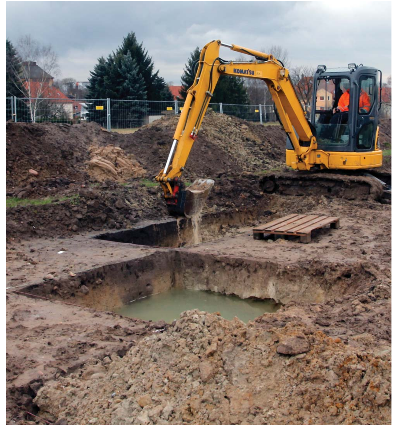
Abb. 8. Bagger beim Wasserschöpfen
