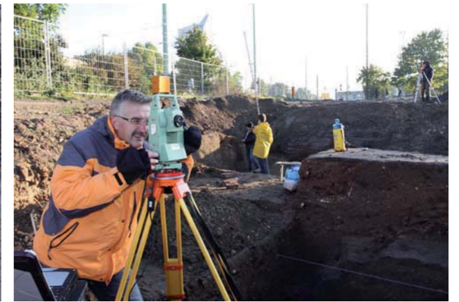
Einmessen der Befunde mit dem Tachymeter
