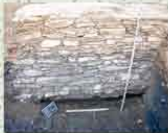
Abb. 24 Die äußere Stadtmauer war tief gegründet
