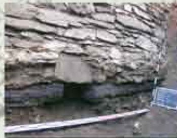
Abb. 25 Das Fundament ruhte auf einer Eichenbohle
