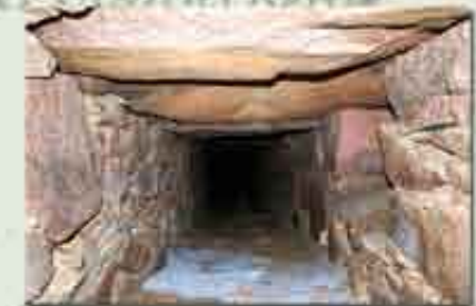
Abb. 13 Blick in einen Hauptsammler aus Phyllitplatten
