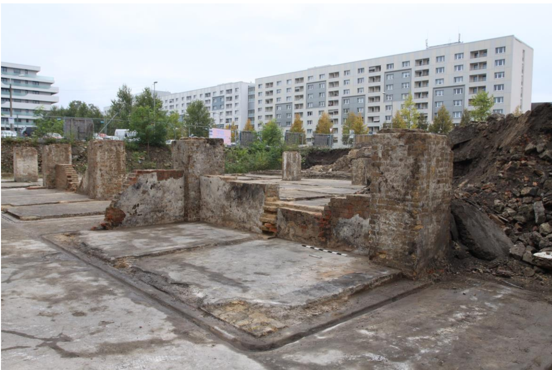
Die Reste der Markthalle, Blick aus Nordost
