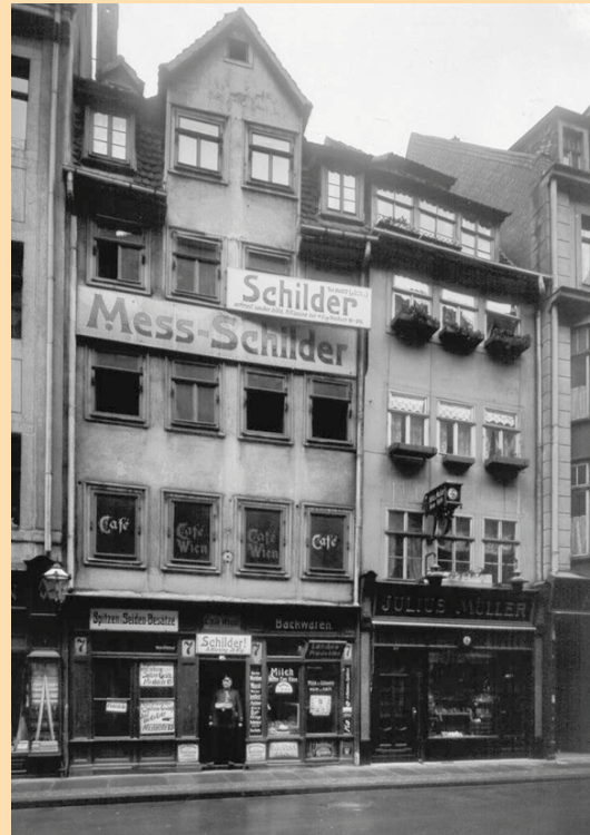
Blick auf die Gebäude Schuhmachergässchen 7 (links) und 9 (rechts)
