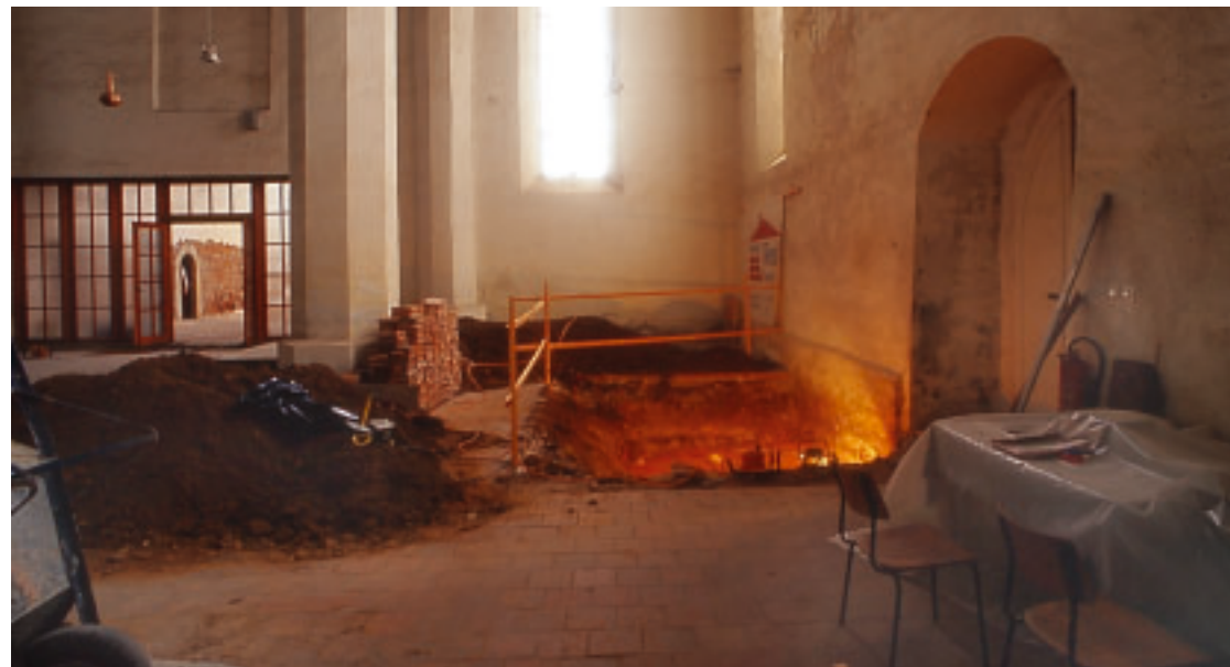
Schachtgrube für die Heizleitungseinführung (beleuchteter Bereich), von Westen (vgl. Ostprofil Seite 3, Planum Seite 4 sowie Südprofil Seite 5).
