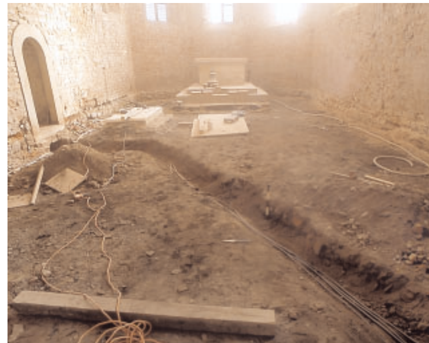
Schachtgraben für die Heizleitung im Chorbereich.
