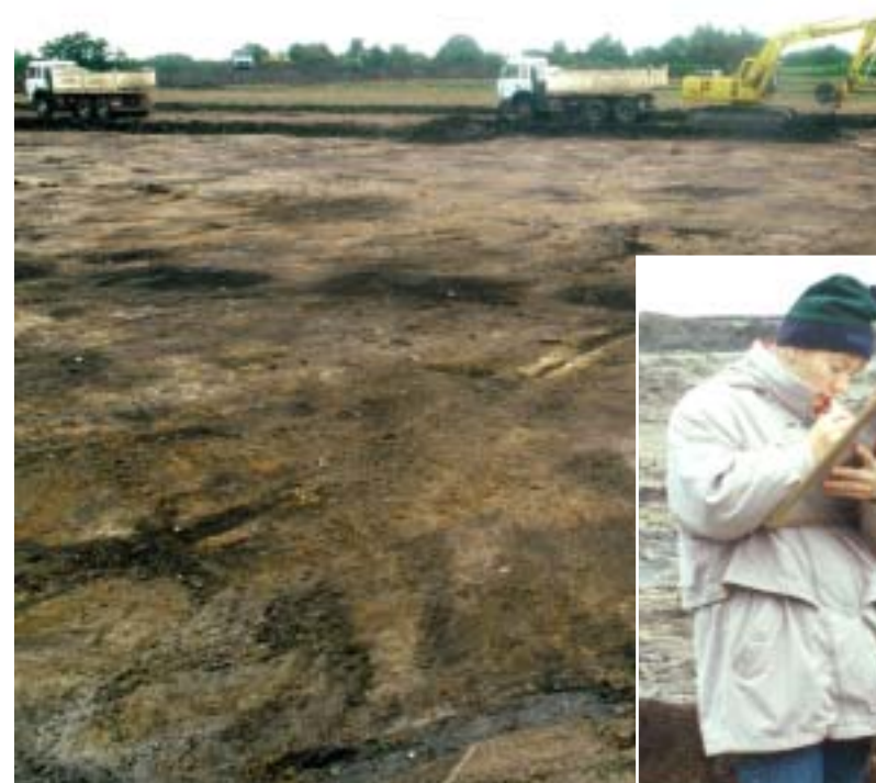
Abtrag des Mutterbodens im Bereich des Baufeldes.
