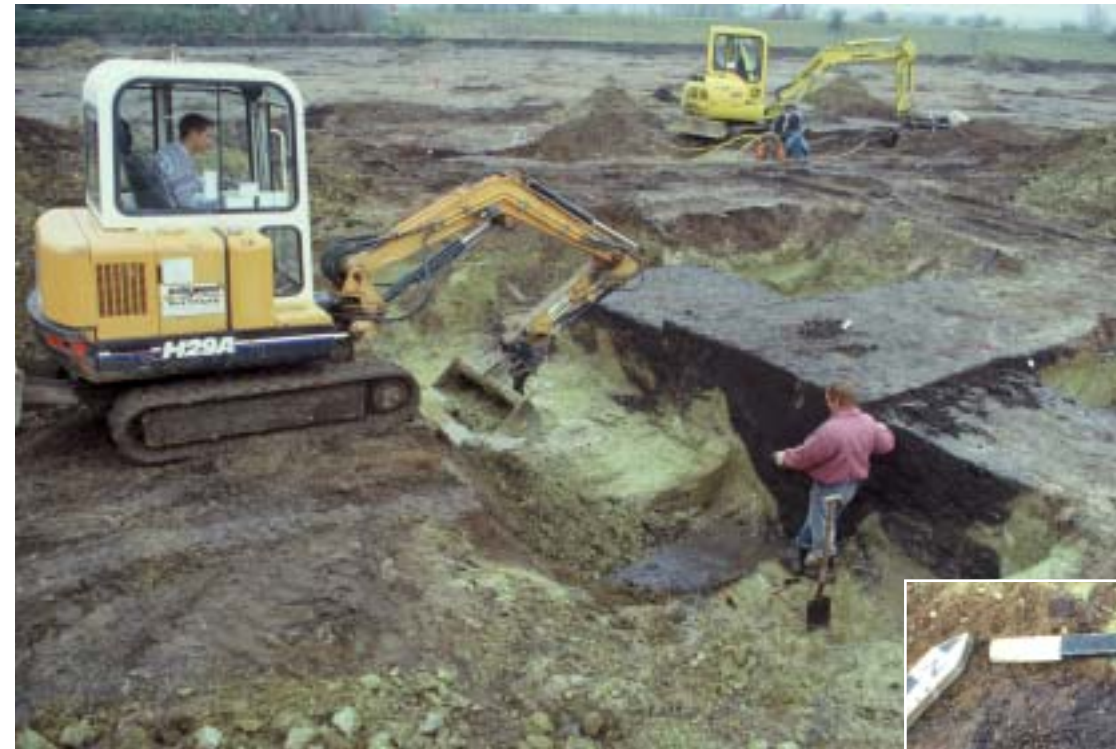
Minibagger unterstützen die Tätigkeit der Archäologen.
