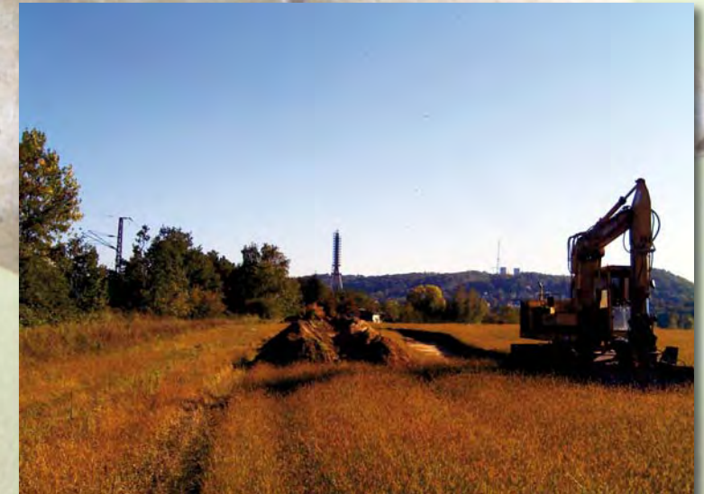
Abb. 14 Zur archäologischen Erkundung werden ausschließlich im Baufeld mit einem Bagger Suchschnitte bis auf den gewachsenen Boden gezogen. Dabei konnten an drei Stellen Siedlungsspuren entdeckt werden. Um diese innerhalb des Baufeldes untersuchen zu können, mussten zusammenhängende Flächen geöffnet werden.
