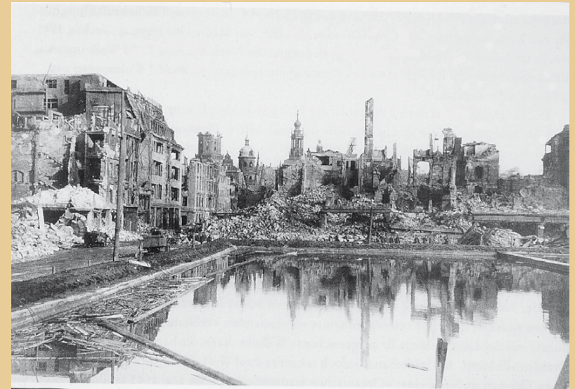
Abb. 6: Altmarkt mit Löschwasserbecken. Blick in die Schlosstraße 1945.
