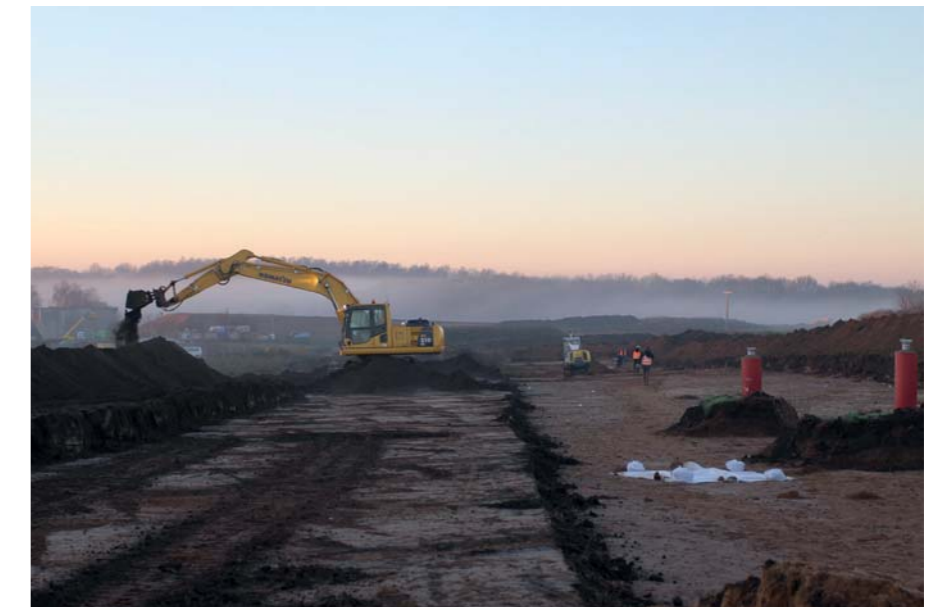
Abb. 53: Baggerabzug der Grabungsfläche, Blickrichtung Südwest
