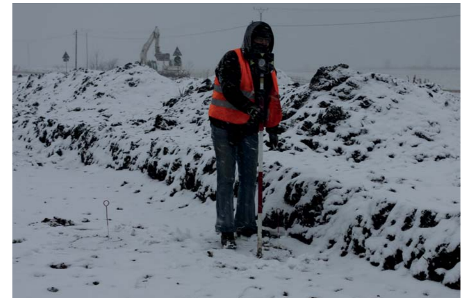
Abb. 68: Vermessungsarbeiten...bei winterlicher Witterung
